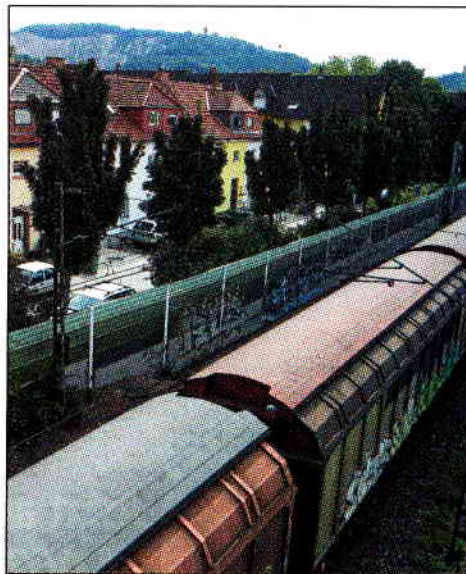
Nur ein Teil der Bahnstrecke durch Weinheim hat Lärmschutzwände. Foto: Kreuzer
